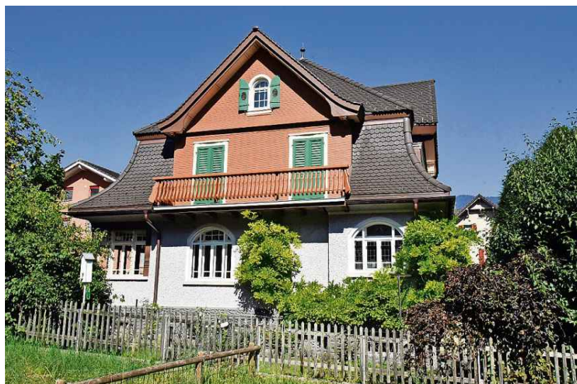
Das Wohnhaus an der Bahnhofstrasse 7 in Sachseln ist für die Architektur von Robert Omlin sehr typisch.
